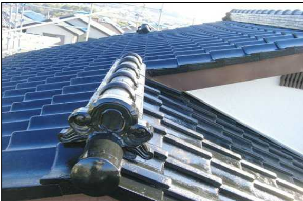
13. 屋根塗装完了 エポキシシーラーとウレタン塗料(2回)を塗りました。
