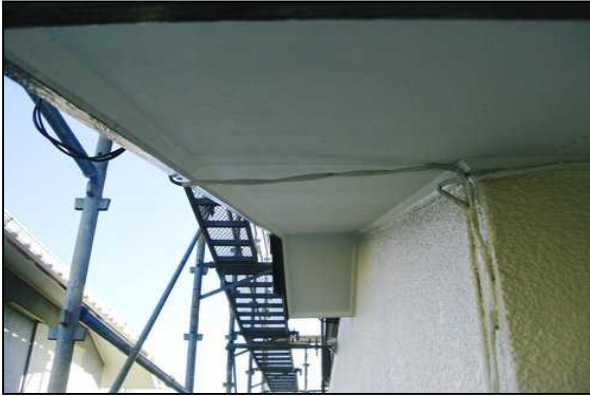
9. 外壁塗装完了 別の角度から撮影。
