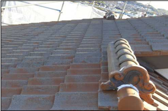
11. 屋根塗装前 瓦の隙間にコーキング剤を入れます。
