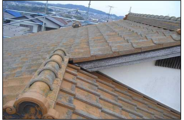
10. 屋根塗装前 セメント瓦です。
