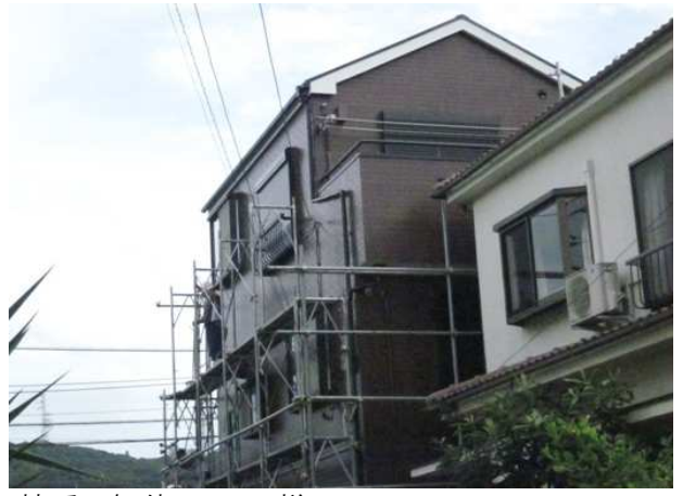
慎重に解体している様子。
