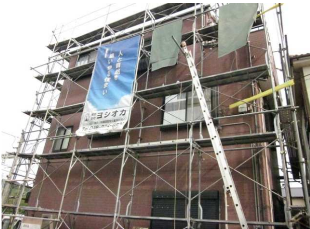
既存の目地を撤去しました。 コーキング施工が綺麗に仕上がるよう、 マスキングテープを貼ります。
