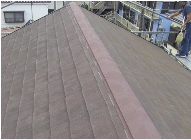
棟板金の設置が完了しました。 (雨水が浸入しないようコーキングは貫板にしています。)
