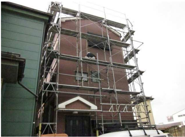
つぎに外壁の目地も修理します。
