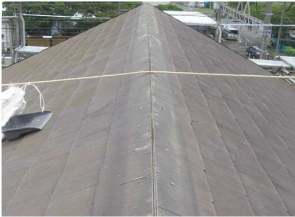
下地の貫板を剥し終わりました。
