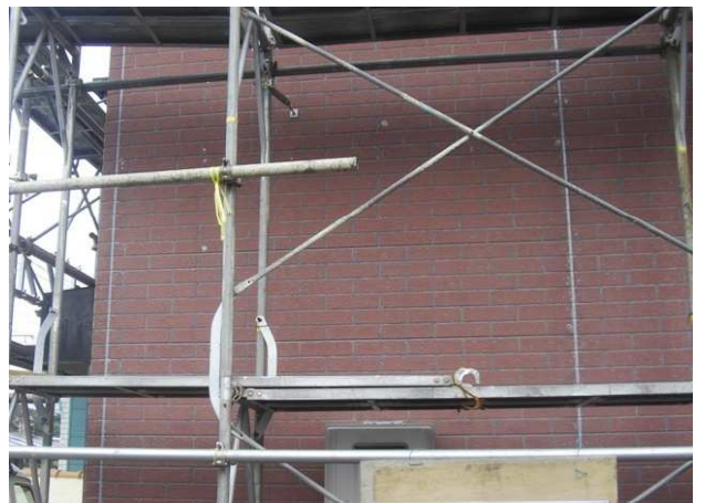
目地のコーキング仕上げが完了しました。
