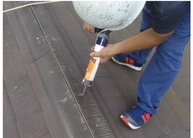
貫板を剥すと釘の穴があります。 コーキングで釘の穴を補修します。 穴が開いたままだとそこから水が浸入してしまいます。 なので、完全に塞ぎます。
