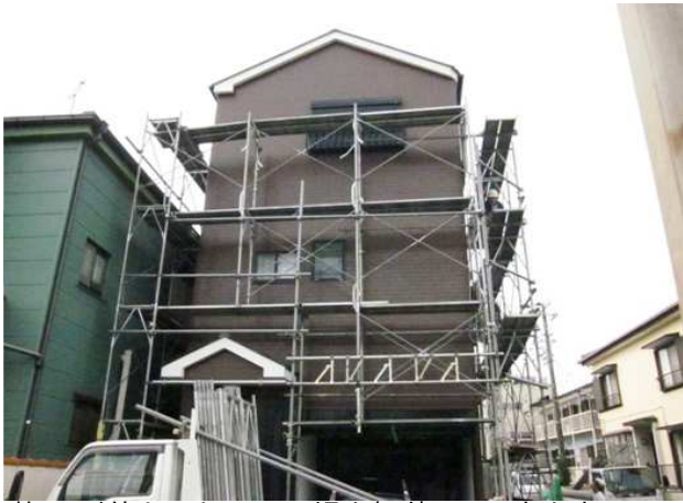
施工が終わったので足場を解体していきます。
