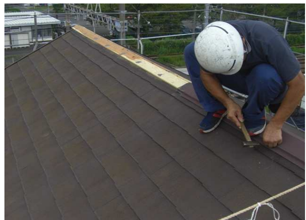
丁寧に釘を打ちます。
