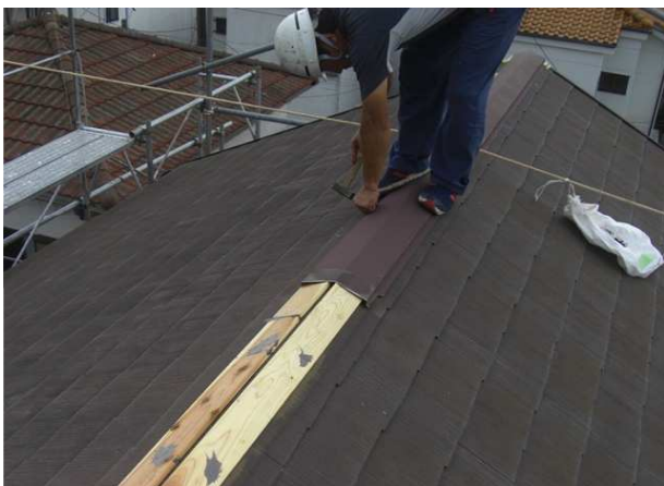
貫板が設置されたら、棟板金を取付けていきます。
