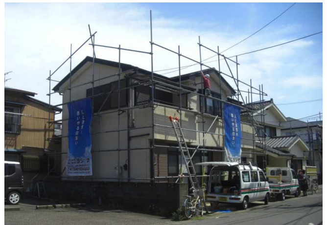
4. 足場組みの状況。
