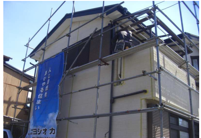
6. 新しくコーキングをする為、マスキングテープを 張ります。
