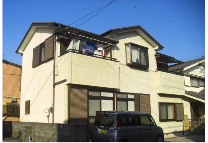
2. 着工前の様子。
