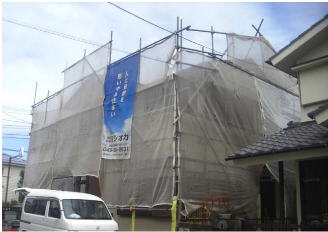
9. 高圧洗浄をしていく為、ネットで養生をします。
