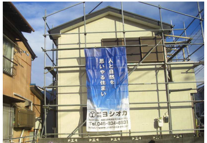
8. 外壁の目地コーキングの施工が完了しました。
