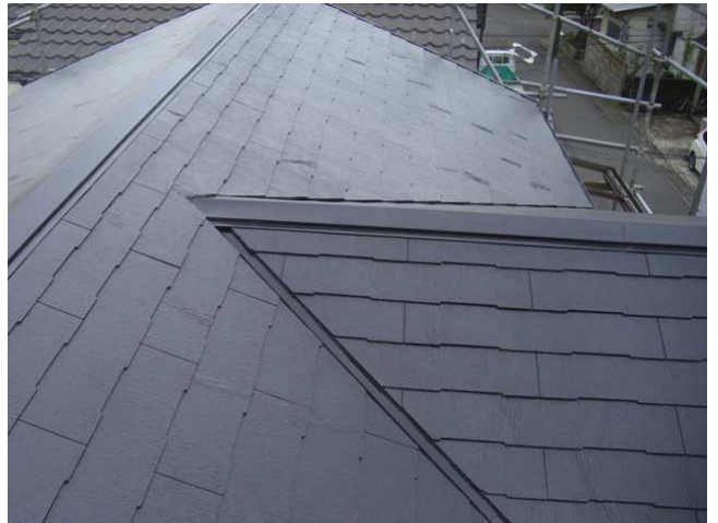
8. コーキングが終わり、屋根の完成。
