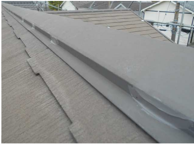
7. 別の箇所に釘を打ち、コーキング施工をしていきます。
