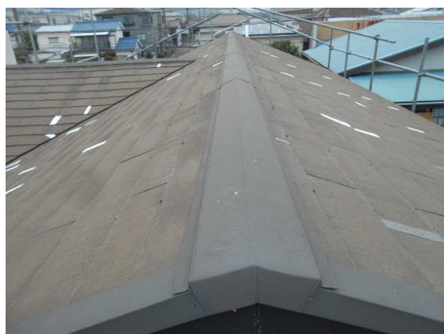
4. コーキングの施工中。
