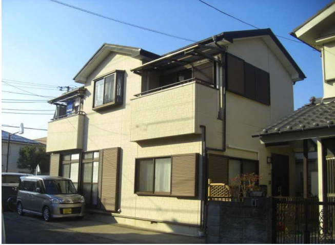
1. 新築してから11年経ち、外壁と屋根を塗装していきます。 着工前の様子。
