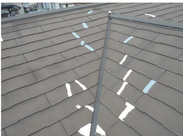
5. コーキングの施工中。
