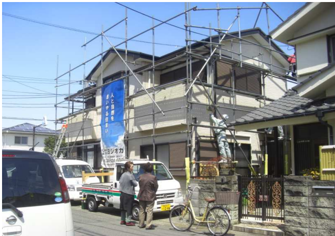
7. マスキングテープ施工中。
