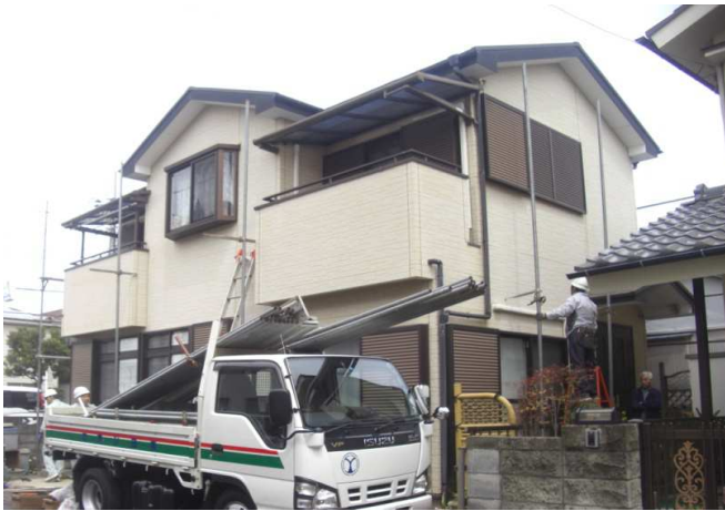
3. 足場を組んでいきます。
