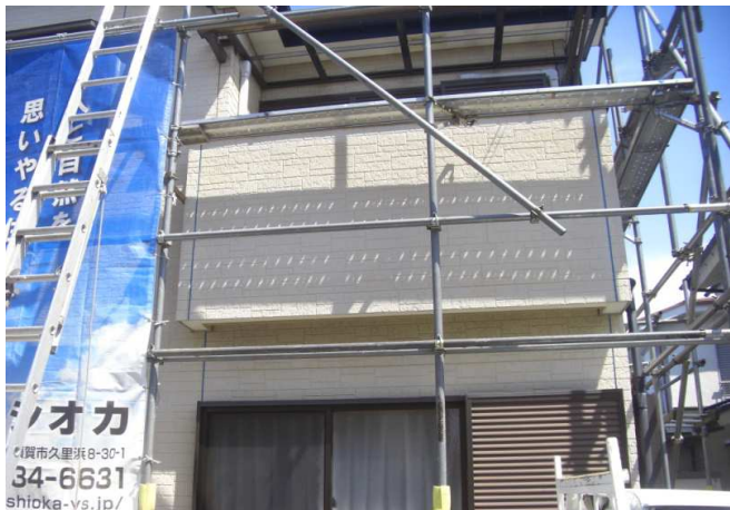
5. 外壁の目地コーキングを撤去します。
