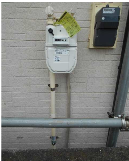
11. ガスメーター配管のバンドを取替えます。
