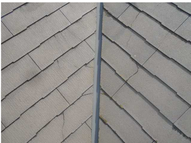
3. 着工前の様子。
