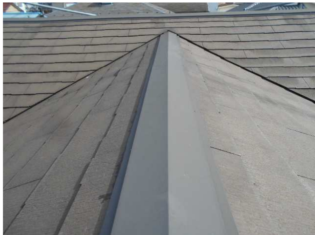
2. 着工前の様子。
