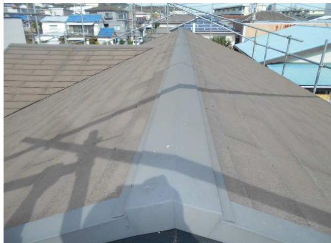
1. 屋根修理の着工前。
