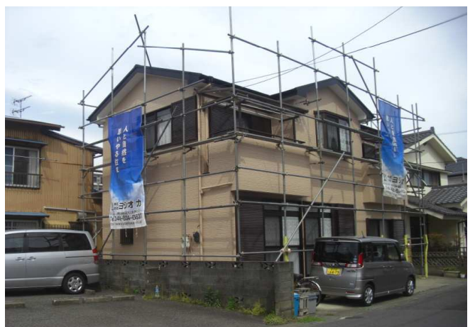
10. 外壁の塗装が完了しました。
