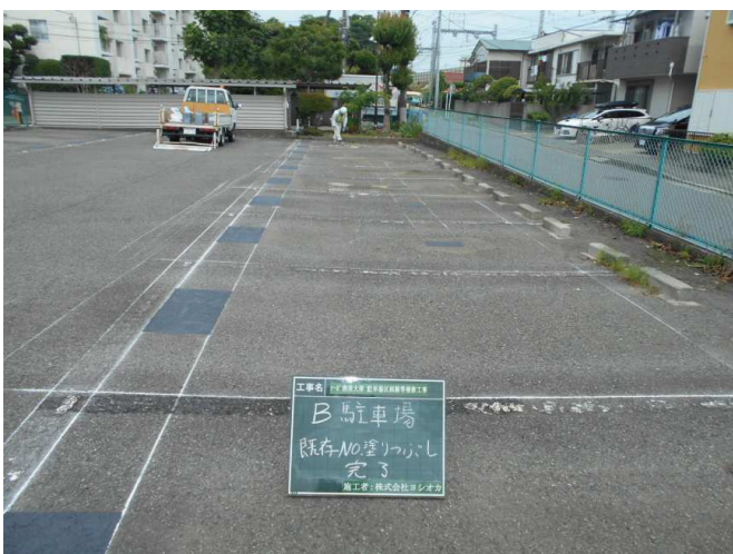
3. 既存ナンバーを塗りつぶして消しました。
