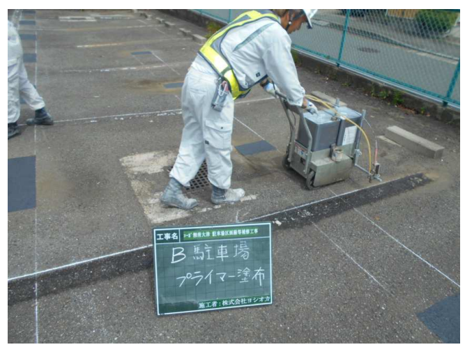
4. 白線の下地となるプライマーを塗っています。
