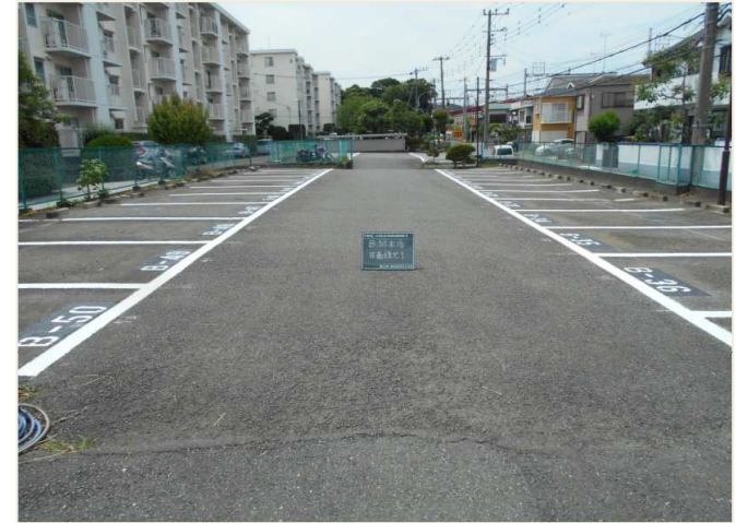
10. ライン引き工事の完成です。
