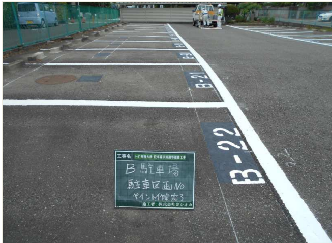
9. 区画番号のペイント作業が完了しました。
