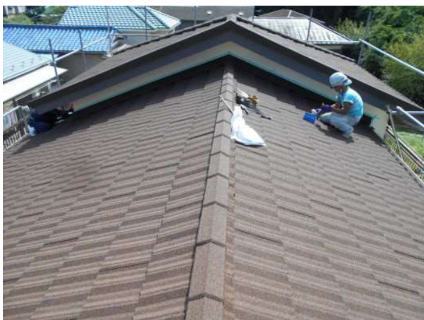
屋根張り完成
