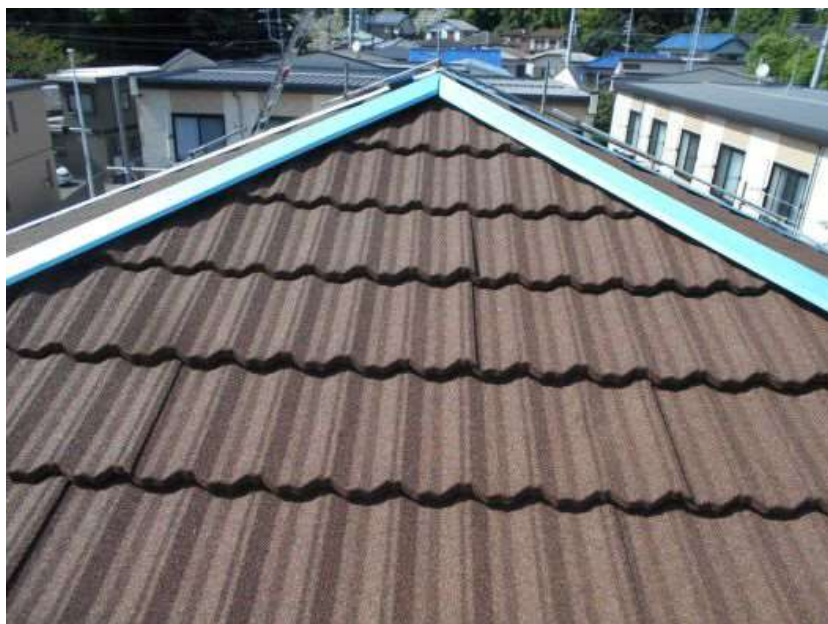
棟カバ一下地材取付け
