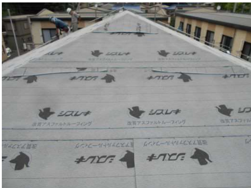
アスファルトルーフィング 張り完了
