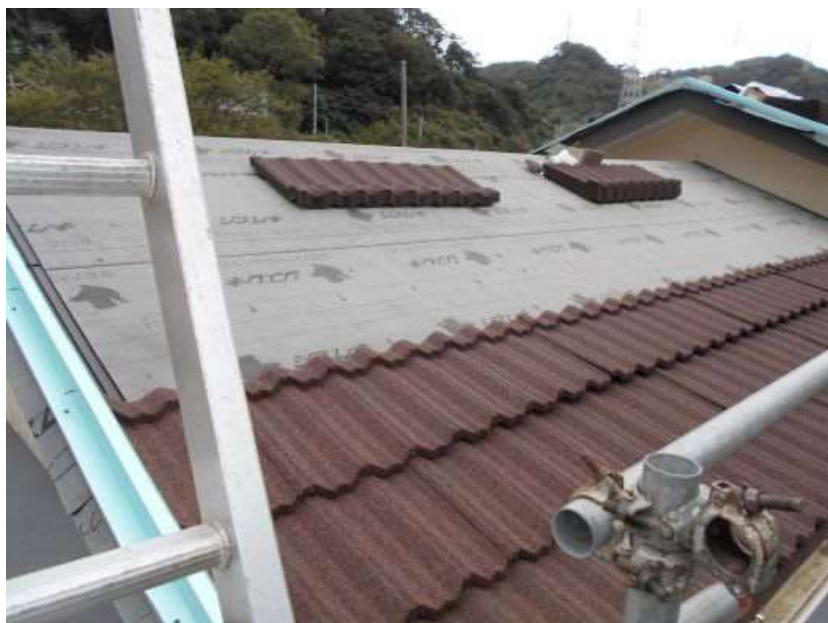
屋根張り状況
