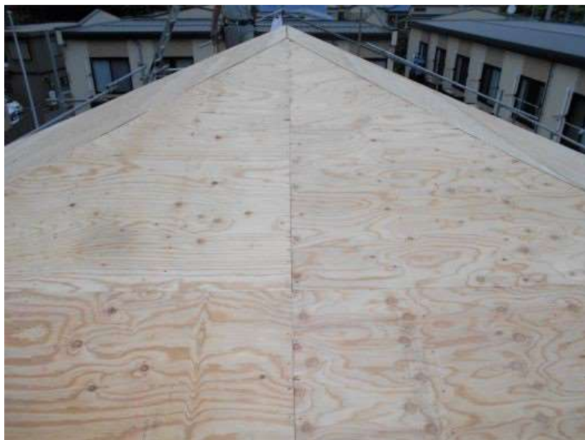
合板張り完了 厚さは12mmです
